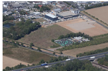
Gewerbegrundstück Bergiusstraße - Vogelperspektive mit Autobahn A 57
